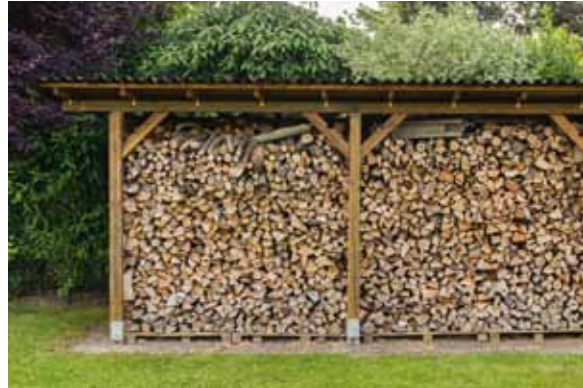
Überdachtes Holzlager ohne Bodenkontakt
