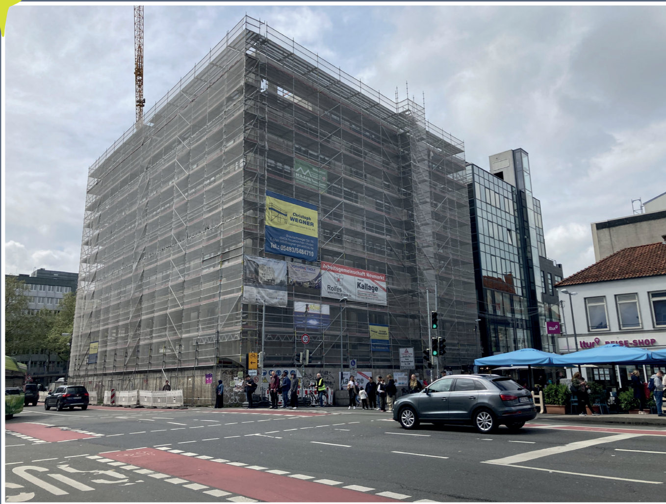
Abbildung 17 - Baulos 2 in der letzten Bauphase. Foto: Stadt Osnabrück
