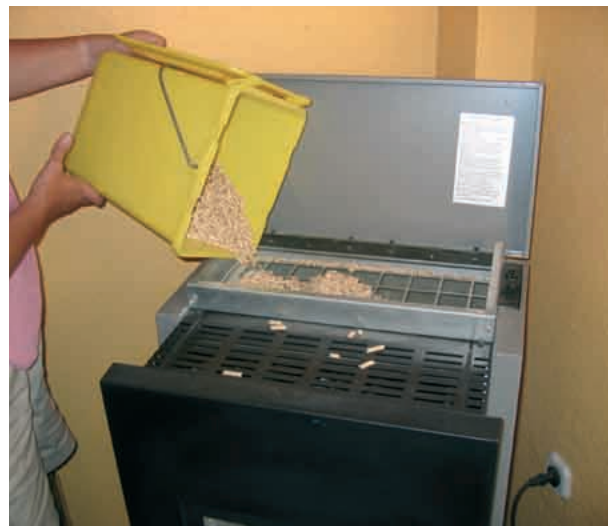
Befüllung eines Holzpellet-Kaminofens
