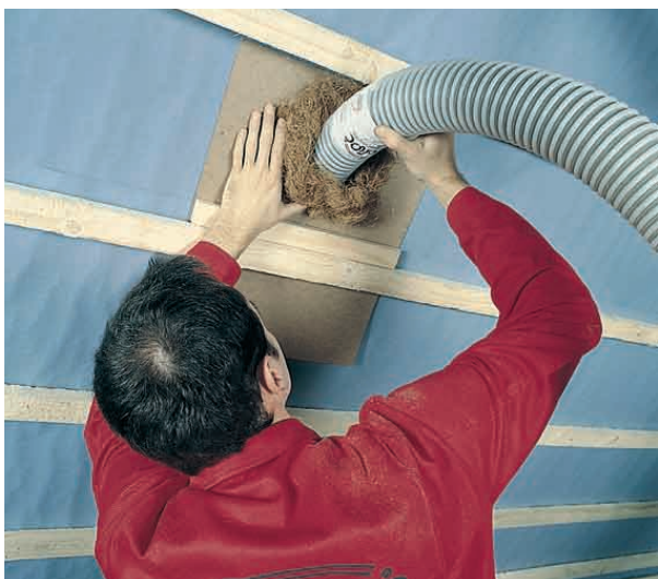
Dachschrägendämmung im Einblasverfahren
