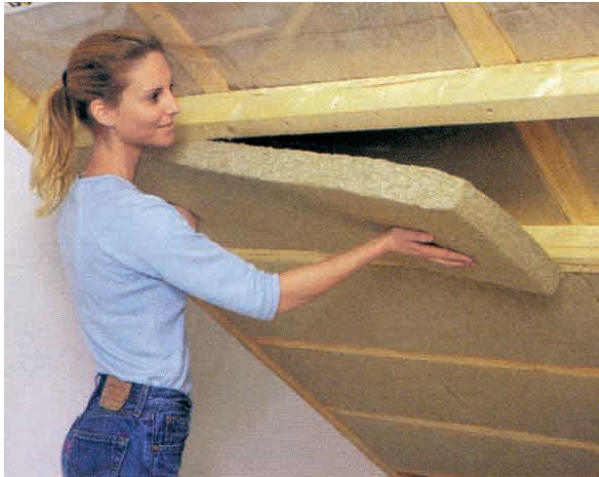
Zusätzliche Untersparren-Dämmung
