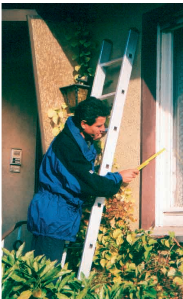
Gebäudeuntersuchung: Aufbau von Wand und Fenster wird bestimmt
