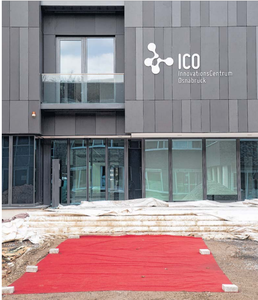
Noch hat der rote Teppich etwas Provisorisches. Doch spätestens zur Schlüsselübergabe soll das Innovationszentrum Osnabrück (ICO), Herzstück des neuen Wissenschaftsparks im Stadtteil Westerberg, fertig sein.
