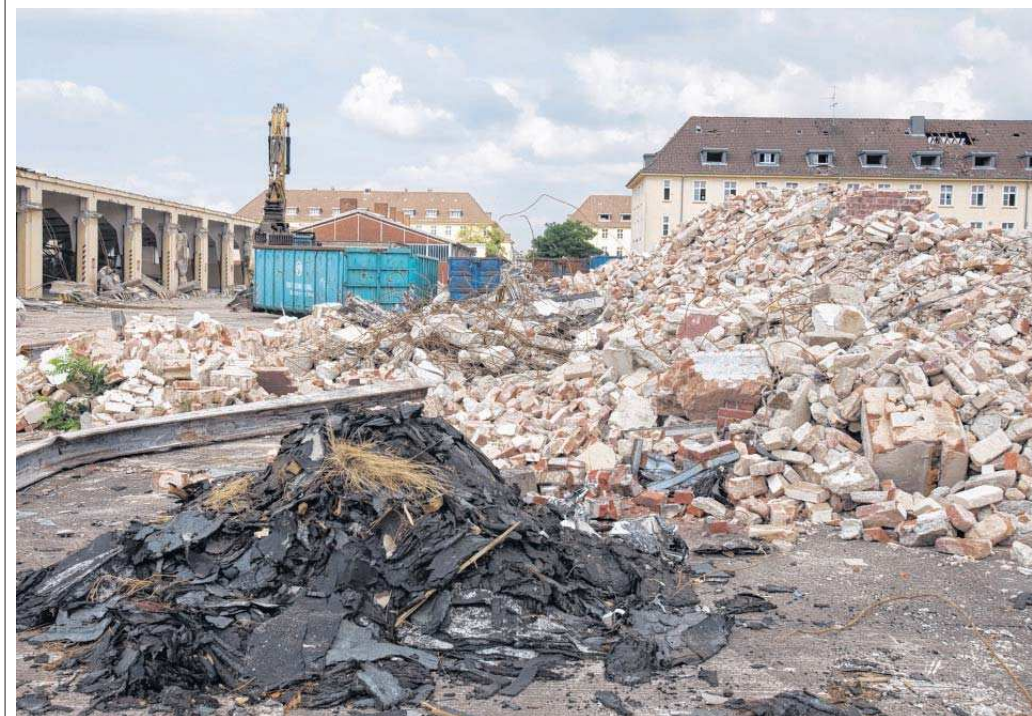
Schuttberge und Wertstoffe türmen sich zurzeit auf dem Gelände der ehemaligen Winkelhausenkaserne. Hier ein Blick in Richtung Westen. Foto: Michael Hehmann
