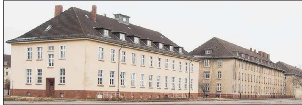
Reif für den Abriss: Teile der Mannschaftsunterkünfte stehen seit Jahren leer.
