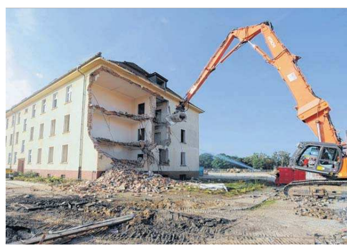
Am langen Arm mit 27 Meter Auslage ist die Abbruchzange von Baggerführer Bernd Santowski befestigt.
