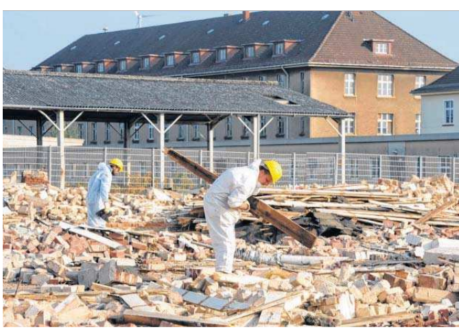
Spezialisten in weißen Anzügen sortieren in Handarbeit Holz, Metall und Schadstoffe aus dem Schutt.
