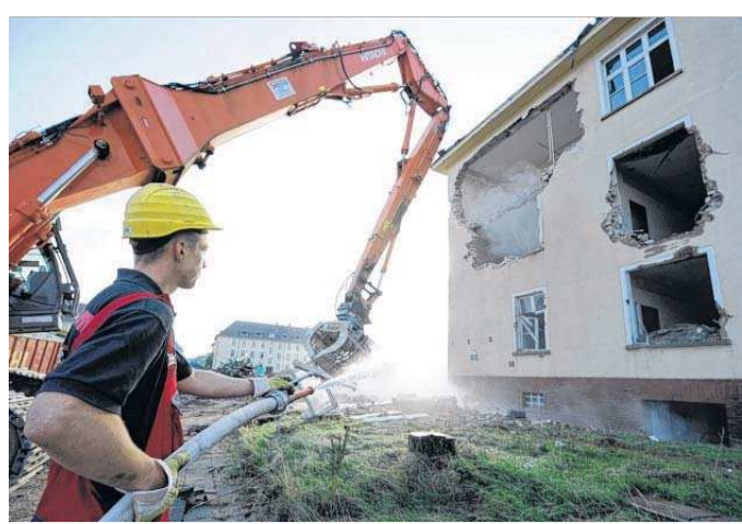
Wenig Staub aufwirbeln ist das Ziel auch bei diesem Abbruch, obwohl das weitläufige Gelände unbewohnt ist.
