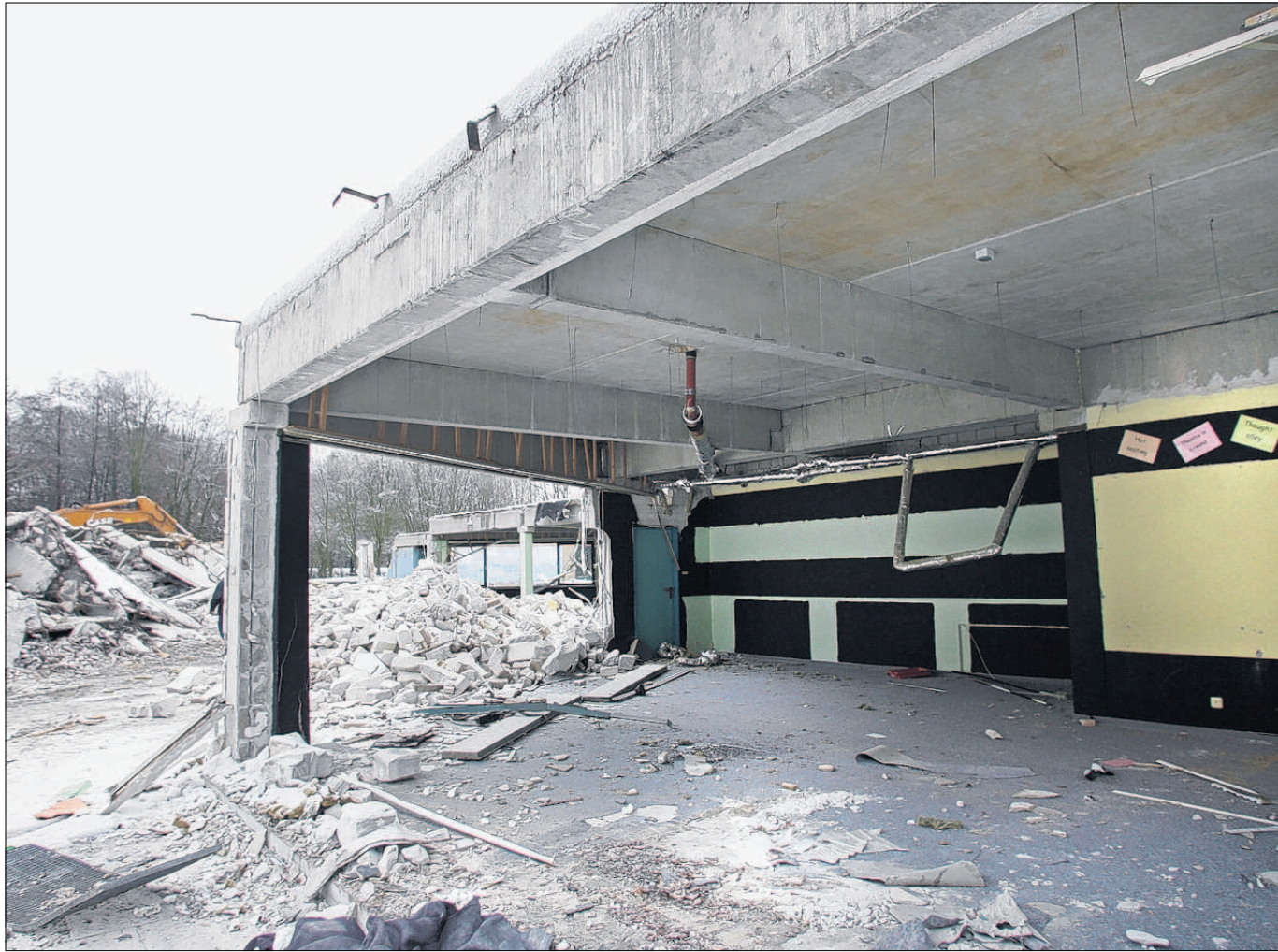
Nur noch wenige Wände sind von der Derby School an der Lerchenstraße geblieben. Das Gebäude wird abgerissen, und die Stadt baut eine neue Förderschule auf dem Gelände.
