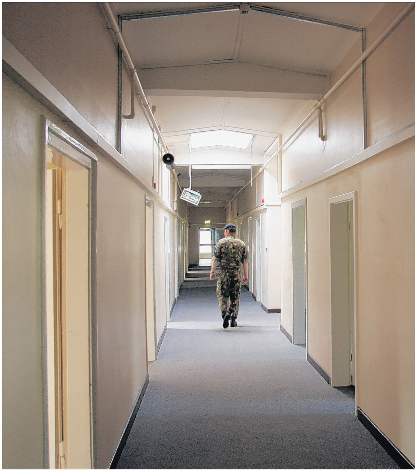
Aus und vorbei: An die 30 Mann haben bis vor wenigen Wochen noch in dieser Baracke aus der Wehrmachtszeit gelebt.
