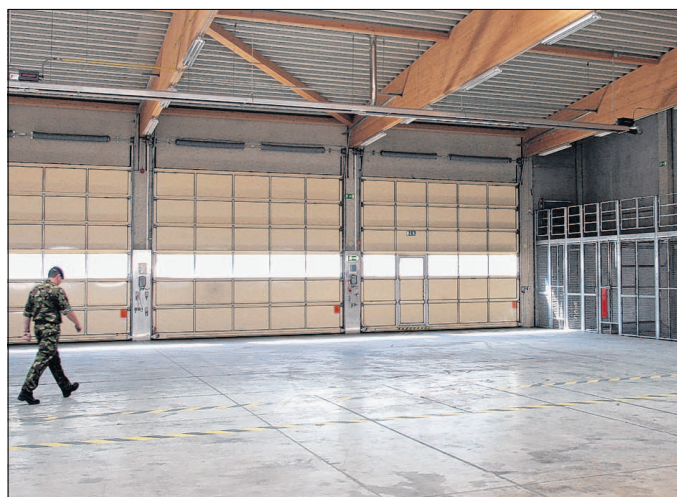
Topmodern ist die Werkstatthalle mit insgesamt zwölf Fahr-gassen, groß genug für Panzer und schwere Lkw.
