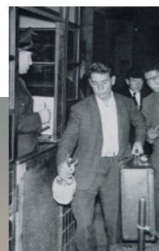
Karmanns erster italienischer Arbeiter am Osnabrücker Bahnhof (1959) © KMO: A 5470
