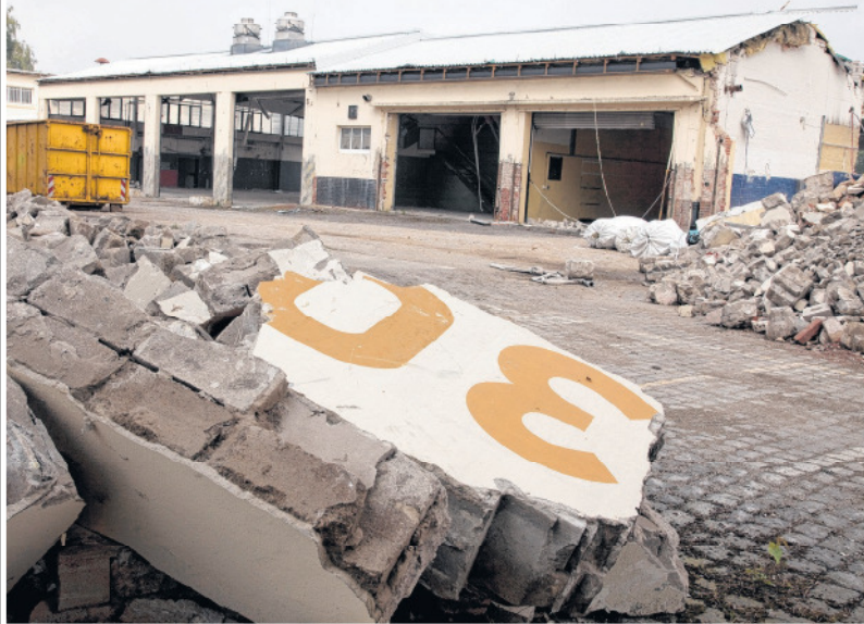
Abriß-Stilleben: Zuerst sind die Briten abgezogen, jetzt muss auch die Scharnhorstkaserne weichen. Auf dem Gelände entsteht in den kommenden Jahren ein Wissenschaftspark.
