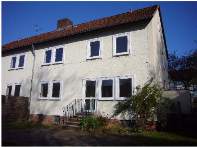
Die Anlage vor der Renovierung: Kleine Fenster, schlechte energetische Qualität
